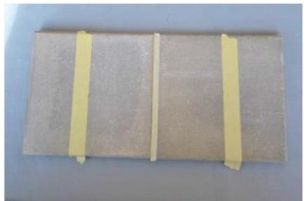
**3** - Applicare l'adesivo epossidico **SYNTECH AS 21** o **SYNTECH AS 31** ai lati del giunto/fessura, facendo attenzione a non coprire assolutamente il nastro adesivo di carta centrale con l'adesivo epossidico.
