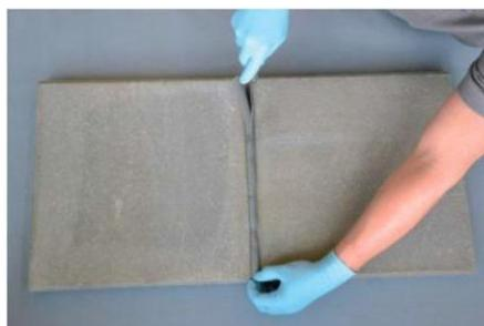
**2** - Applicare un nastro adesivo di carta sulla parte superiore del giunto/fessura (nastro adesivo = doppio della larghezza del giunto). Applicare un altro nastro adesivo di carta su ogni lato del giunto prima di applicare l'adesivo. La distanza dal congiunto dovrebbe essere di circa una volta la dimensione completa del nastro **ELASTOTEX (170-220-325-550)**.
