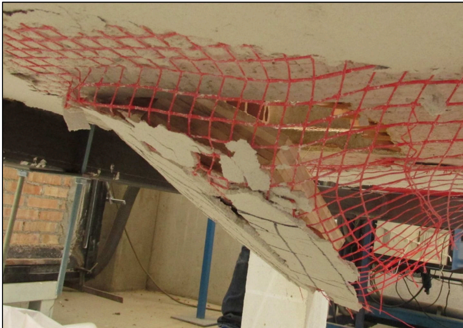
Fotografie della rottura dopo la prova n. 3 avvenuta nella porzione laterale in prossimità del bordo del solaio
