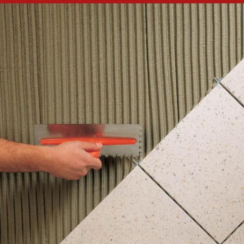
Adesivo cementizio monocomponente, certificato in classe C2TE secondo EN 12004, a base di leganti idraulici ad elevata finezza, promotori di adesione amido-derivati, sabbie selezionate silico-calcaree, filler reattivi ad elevata pozzolanicità, addensanti cellulosici, da utilizzarsi per l'incollaggio di piastrelle, ceramiche, gres, pietre naturali e/o ricostruite, su superfici orizzontali e verticali, interne ed esterne.
