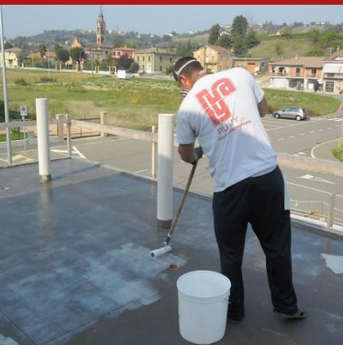
Syntech Poliurea Primer – Epoxy è un promotore di adesione basato su resine epossidiche bicomponenti modificate ed indurenti speciali, esente da solventi. Formulato appositamente per fornire il giusto compromesso tra impregnazione e bagnabilità del supporto sul quale, una volta applicato, forma uno strato preparatorio ben adeso, ideale per ricevere rivestimenti poliureici o epossidici.
