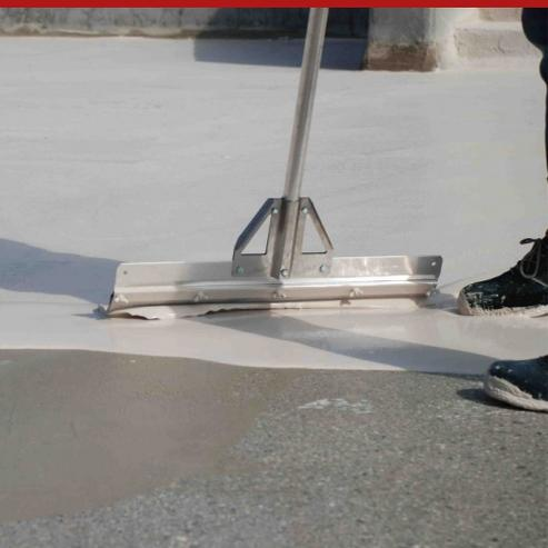
Formulato tricomponente, a base di resine epossidiche fluide in emulsione acquosa (A+B), da miscelare con il terzo componente (C) costituito da cemento e microquarzo bianco, appositamente studiato per l'utilizzazione come fondo per supporti di diversa natura in presenza di umidità e in condizioni di risalita capillare.
