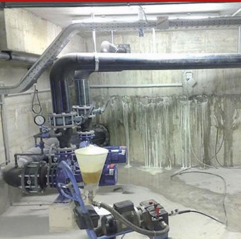
Resina poliuretana monocomponente idroespansiva (non necessita di catalizzatore e aumenta il proprio volume iniziale di circa 3 volte), esente da solventi, ideale per sigillare, mediante iniezione, piccole e grandi infiltrazioni d'acqua nel calcestruzzo o nelle murature piene in genere. Ideale per colmare grandi vuoti e vespai interni alle murature. Reagisce con l'acqua e forma una schiuma flessibile a cellule chiuse. Sviluppato per l'applicazione in strutture umide e asciutte.
