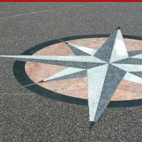
Legante bicomponente a base di polimeri poliuretano alifatici utilizzabile come legante per la realizzazione di pavimentazioni continue drenanti, pedonali e carrabili con inerti selezionati. L'impiego di aggregati naturali di colore, forma e dimensione diverse, permette la realizzazione di tantissime soluzioni personalizzate per ogni esigenza progettuale.
