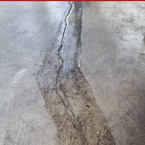
Riempitivo bicomponente a base di resine epossidiche, ad alto solido, utilizzabile con quarzo e/o cariche inerti per la riparazione di crepe nelle pavimentazioni in calcestruzzo.
