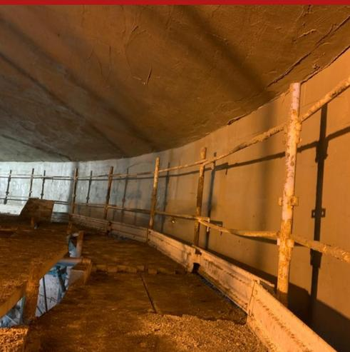
Rivestimento antiacido a base di polimeri epossidici e polisolfurici modificati, per il rivestimento impermeabile di vasche, serbatoi, cisterne di contenimento in calcestruzzo e acciaio.
