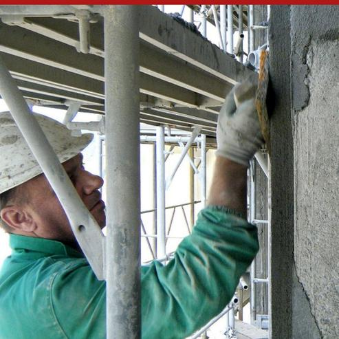
Malta da ripristino tixotropica, antiritiro, fibrorinforzata, idonea per il risanamento del calcestruzzo ammalorato e per interventi di carattere strutturale sulle murature. Repar Tix R3 è una malta a base di leganti idraulici a basso tenore di sali solubili, filler superpozzolanici, agenti antiritiro, aggregati selezionati in razionale distribuzione granulometrica, microfibre sintetiche ad alte prestazioni.
