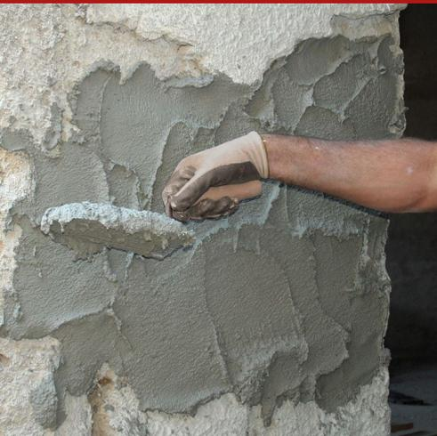
Malta cementizia da rinzafo, monocomponente, super-adesiva, a base di leganti ad alta resistenza, aggregati selezionati, polimeri promotori d'adesione ed agenti specifici. Specifica per il trattamento preliminare a "rinzafo" di superfici in calcestruzzo, murature miste, pareti rocciose e altre superfici poco assorbenti, per il successivo rivestimento con intonaci tradizionali (Intosana), deumidificanti (Sanatigh) e/o termo-isolanti (Sanawarme o Caleosana).
