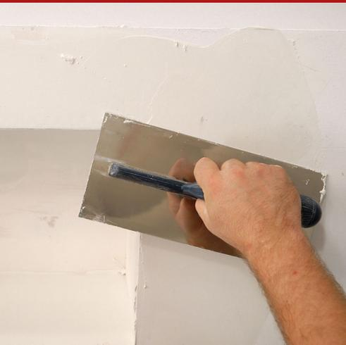
Rasante cementizio tixotropico strutturale, fibrorinforzato, con ottime caratteristiche di adesione, resistenza a compressione, resistenza a flessione, resistenza all'abrasione, ecc.. Ideale per interventi di risanamento strutturale di opere e manufatti in calcestruzzo degradato. Applicabile a cazzuola e frattazzo.
