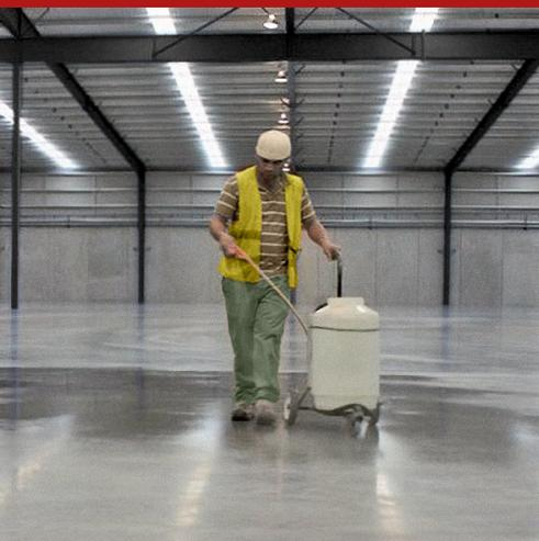
Impregnante a base di sale sodico dell'acido silicico in soluzione acquosa per il trattamento protettivo del calcestruzzo. Riduce drasticamente la permeabilità all'acqua del manufatto mantenendo il passaggio al vapore acqueo. Di conseguenza aumenta la resistenza all'aggressione acida e la durabilità dell'opera in calcestruzzo.
