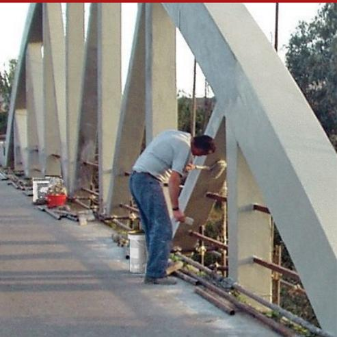
Pittura anticarbonatativa, protettiva, decorativa, pigmentata per la tinteggiatura di superfici in calcestruzzo; a base di resine acriliche in emulsione acquosa, forma un film impermeabile all'acqua, con bassissima permeabilità all'anidride carbonica ma elevata permeabilità al vapore, ancorato per aderenza specifica e diffusione. Ideale per rivestimenti protettivi di opere infrastrutturali in calcestruzzo.
