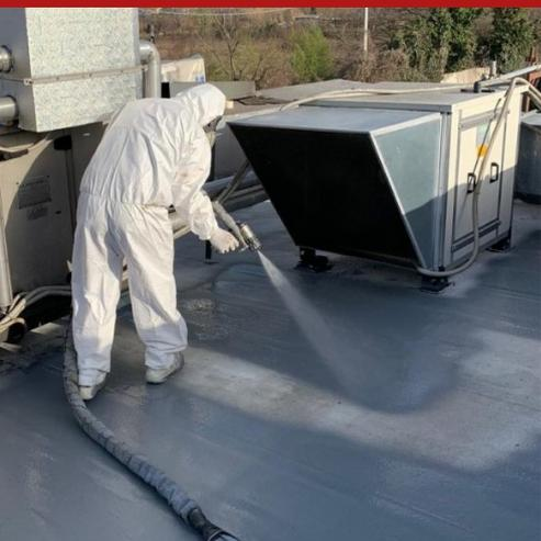
Syntech Poliurea Spray - N è una poliurea pura al 100% di tipo aromatico. Non contiene VOC ed è applicabile solo a spruzzo per mezzo di macchine bimixer idonee che vaporizzano il materiale a caldo. Syntech Poliurea Spray - N è un elastomero di rivestimento caratterizzato da un alto grado di allungamento, ottenuto dalla reazione di un isocianato di tipo aromatico con una ammina. Entrambi i materiali sono estremamente fluidi e con bassa viscosità ed hanno la proprietà di reagire molto velocemente.
