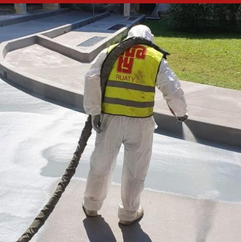
Syntech Poliurea Spray - FL è una poliurea pura studiata per l'applicazione specifica su pavimentazioni carrabili e parcheggi in genere. 100% solida non contiene VOC ed è applicabile solo a spruzzo per mezzo di macchine bimixer idonee. È un elastomero di rivestimento caratterizzato da un alto grado di allungamento, ottenuto dalla reazione di un isocianato di tipo aromatico con una ammina.
