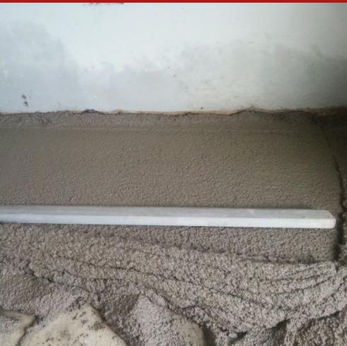
Premiscelato fibrorinforzato, a base di calce idraulica, inerti leggeri ad elevata porosità comunicante e farine di sughero, per la realizzazione, con la sola aggiunta dell'acqua, di massetti e sottofondi leggeri, ad elevato isolamento termico ed acustico, negli interventi bioedili e nel restauro di edifici d'epoca e monumentali. I massetti Sanalit, confezionati secondo le specifiche riportate nella presente scheda tecnica, sono classificati C5-F1-A22 in accordo alla normativa europea EN 13813.
