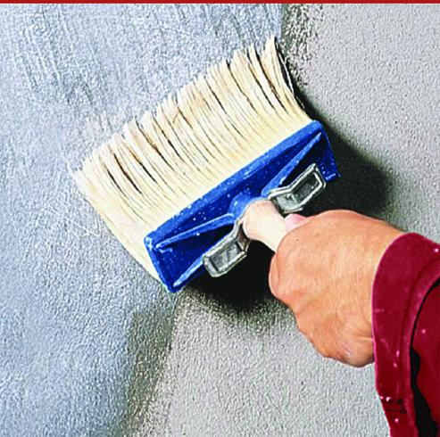
Sottofondo murale all'acqua anticondensa per interni ed esterni, con ottime proprietà fissative, ancoranti, con buona copertura a base di resine acriliche ad alta penetrazione, microsferi di vetro cave (3M Glass Bubble - conducibilità termica 0,08 W /mK), pigmenti, cariche e filler coprenti. Idoneo come primer fissativo anticondensa, preliminare alla tinteggiatura o al rivestimento degli intonaci con pitture o intonachini anticondensa (-THERM).
