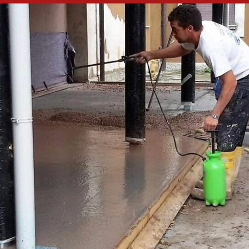
Ritardante di presa in soluzione acquosa da applicare, mediante pompa airless a bassa pressione, sulle superfici di calcestruzzo fresco, per permettere di poter asportare mediante idrolavaggio, uno strato corticale di pochi millimetri, e quindi esporre gli inerti costituenti il conglomerato cementizio. Specifico per la realizzazione di pavimenti di valenza paesaggistica/ambientale con la tecnica del "ghiaietto lavato".
