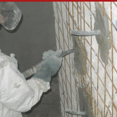
Boiaccia cementizia superfluida, iniettabile, ad elevatissima scorrevolezza e stabilità, moderatamente espansiva in fase plastica, per fissaggi, ancoraggi, consolidamenti murari, colmature, riempimenti di guaine di post-tensione ecc., a base di cementi ad alta resistenza, additivi specifici, filler reattivi superpozzolanici. Massima dimensione particellare 0,06 mm.
