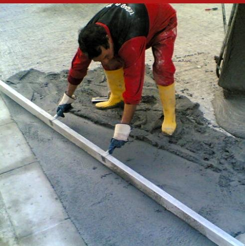
Betoncino cementizio reoplastico, composito, a ritiro controllato, consistenza superfluida, fibrorinforzato con uno speciale mix di fibre di vetro e polipropileniche (in acciaio a richiesta), a base di cementi ad alta resistenza, modificanti polimerici, agenti antiritiro, filler reattivi superpozzolanici, aggregati silicei selezionati. Ideale per la ricostruzione dello spessore del calcestruzzo asportato mediante fresatura, adeguamenti dimensionali, reintegri strutturali, ecc..
