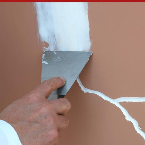
Stucco adesivo, di colore bianco, per la stuccatura e la colmatura riempitiva di crepe, fessure e piccole disomogeneità su intonaci e facciate, anche in abbinamento a Sanaxil Filler.
