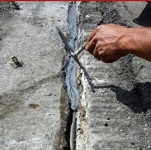
Sigillante epossi-poliuretano elastoplastico bicomponente, plastico fluido, per giunti sottoposti a traffico: durezza Shore A = 65; allungamento a rottura 70%; da spatolare o estrarre nelle sezioni di giunto opportunamente nastrate (per proteggere le superfici adiacenti). Resistente al contatto con idrocarburi (benzina e gasolio).
