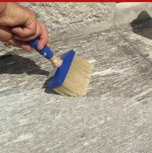
Consilex Idroplus è un idrorepellente siliconico concentrato, formulato per l'idrofobizzazione, il trattamento antisalino ed il consolidamento di materiali minerali da costruzione assorbenti anche alcalini. VOC = 0
