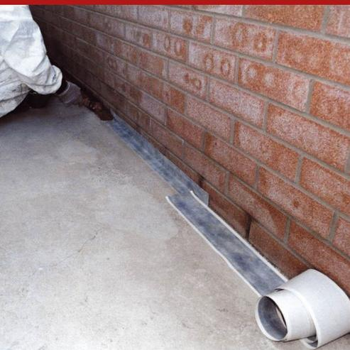
Nastro adesivo, a freddo, idrorepellente, composto da uno strato a consistenza visco-elastica in gomma butilica, rivestito con un tessuto non-tessuto, in polipropilene, per l'impermeabilizzazione elastica di giunti non strutturali in balconi, terrazze, ecc.. Dimensioni della bandella: 80 mm x 0.9 mm.
