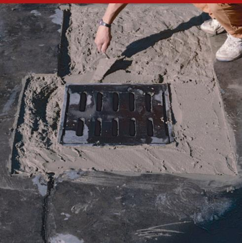
Malta strutturale, fibrorinforzata con microfibre d'acciaio, a rapido indurimento, a base di cementi portland, leganti speciali, aggregati silicei selezionati ed agenti specifici di reologia, per riparazioni, ricostruzioni ed ancoraggi caratterizzati da un rapido sviluppo di resistenze meccaniche anche a basse temperature.
