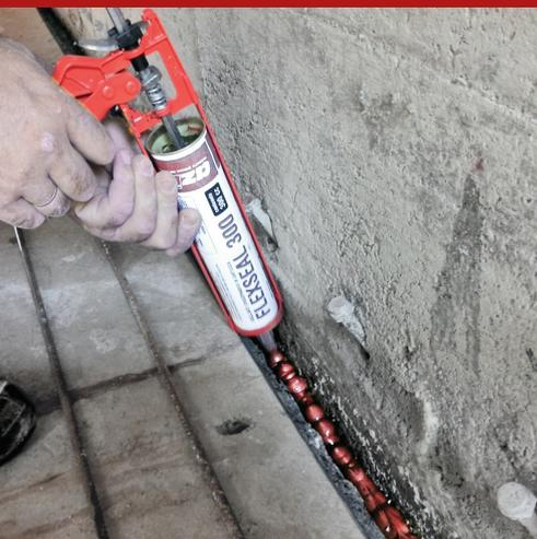
Sigillante poliuretano idroespansivo, in pasta tixotropica, preconfezionato in cartuccia estraibile con normali pistole dosatrici, da utilizzare come waterstop nelle situazioni più complesse o disagiate nell'ambito delle impermeabilizzazioni di locali interrati. Mantiene inalterate nel tempo le proprie caratteristiche elastiche ed ermetizzanti. In uno stato completamente asciutto, Flexseal 300 si restringe alle sue dimensioni originali e si espande quindi nuovamente al contatto con l'acqua.
