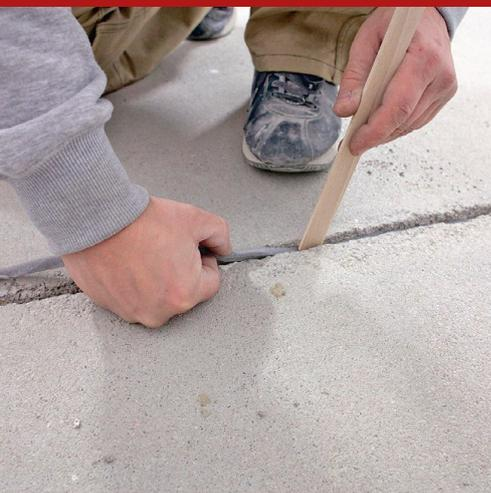
Cordone in polietilene espanso a celle chiuse, comprimibile, per dimensionare correttamente la profondità dei giunti di dilatazione (creazione della "terza parete" o fondo del giunto) prima di essere riempiti con i sigillanti polimerici Protech Flex o EG 91. E' disponibile in profili di sezione circolare di diverso diametro che si adattano a giunti di qualsiasi forma e dimensione.
