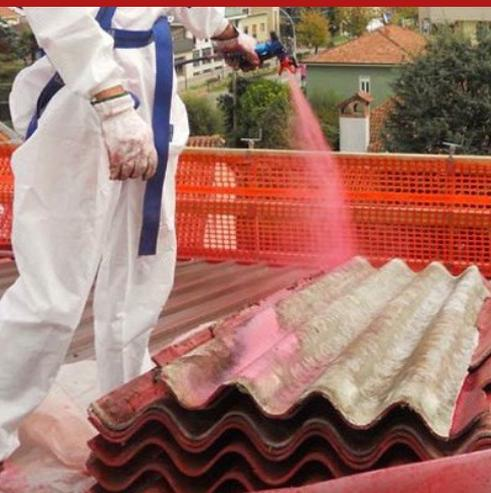
Lattice fissativo, penetrante, consolidante, di tipo reattivo flessibilizzante, a base di copolimeri stirene butadiene in emulsione acquosa, per l'incapsulamento temporaneo di tipo D di lastre in amianto nelle operazioni di disinstallazione e rimozione, addizionato con pigmenti inorganici di colore rosso, per migliorare la visualizzazione delle superfici trattate.
