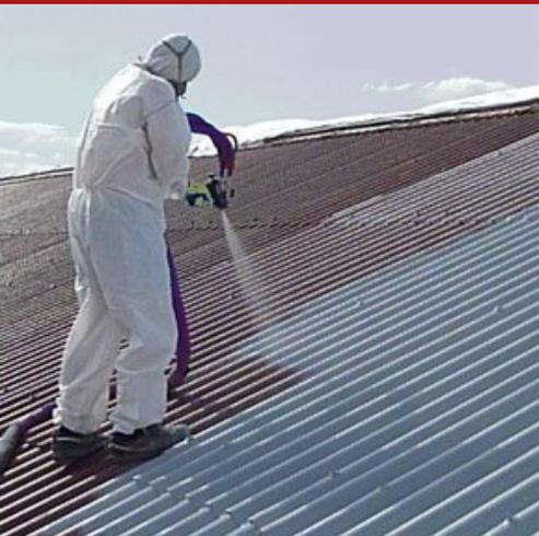
Rivestimento monocomponente a base di resine acriliche in dispersione acquosa per l'incapsulamento permanente di tipo A (a vista all'esterno), B (a vista all'interno) e C (non a vista, prima di un confinamento) di lastre in amianto, certificato in conformità al D.M. 20 Agosto 1999. Elastocap-ABC è caratterizzato da elevata flessibilità, resistenza all'ingiallimento, adesione e realizza una membrana impermeabile e resistente alla fessurazione.
