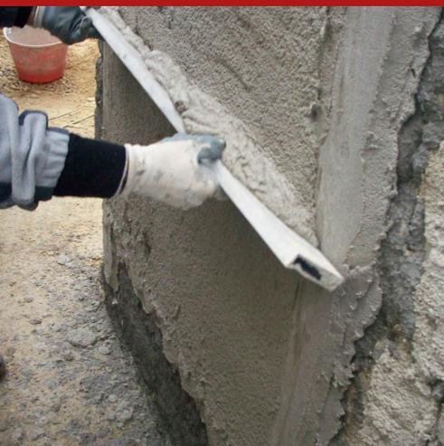
Intonaco per interni ed esterni, macroporoso, bioedile, ad elevate prestazioni termoisolanti, a base di calce idraulica naturale NHL 3,5, inerti silicei, metacaolino, silice espansa granulare con altissimo volume di vuoti intercomunicanti e basso modulo elastico. Le sue peculiari caratteristiche lo rendono idoneo per la deumidificazione, il risanamento termico ed igrometrico di edifici e murature, negli interventi bioedili e nel restauro di edifici d'epoca e monumentali.
