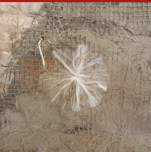
Connettore in fibra di vetro alcali resistente, con segmento centrale preformato rigido e doppia estremità sciolta, sfiochettiabile. Adatto per il rinforzo strutturale di murature, archi e volte in laterizio, tufo e pietra, in combinazione con le reti in fibra di vetro ARMAGLASS STRUTTURA e malte tipo Unisan, Intosana e della famiglia REPAR. Si utilizza come connessione passante per il collegamento dei due lati di un'intonacatura strutturale (tecnica del "sandwich strutturale").
