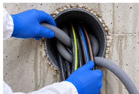
03 - Inserimento del FILTENE FONDOGIUNTO
