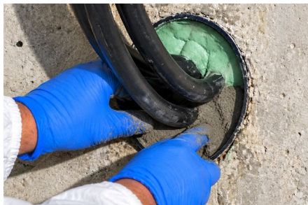
10 - Posa della malta REPAR TIX G2
