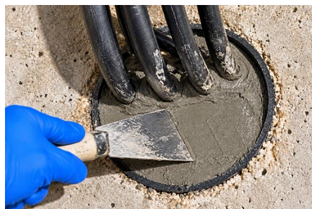
11 - Rasatura della malta con piccola spatola
