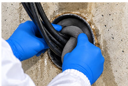
01 - Verifica del passaggio cavi
