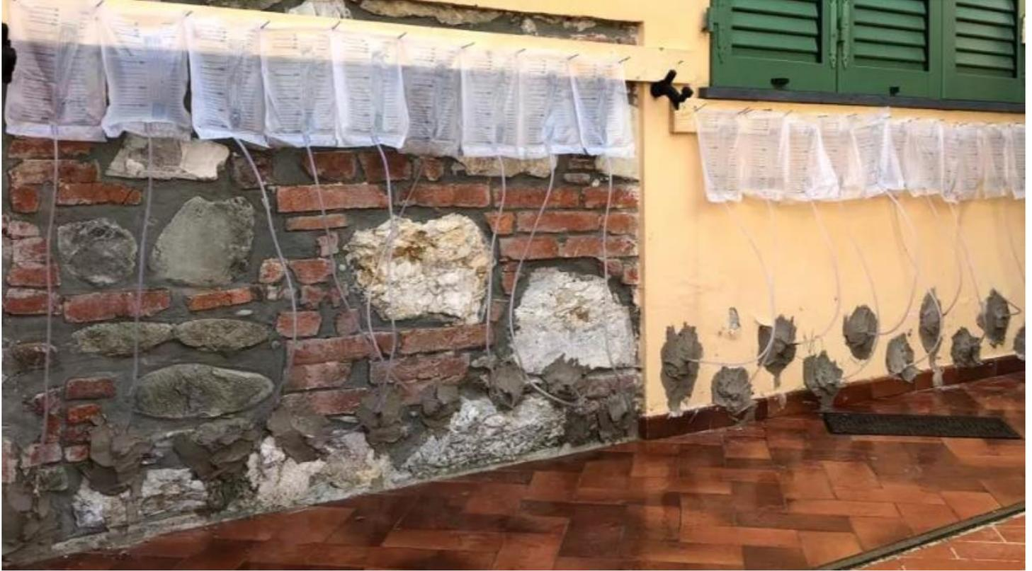
Corretta procedura per la realizzazione di una “barriera chimica a lenta diffusione” da realizzarsi su murature in mattoni pieni, tufo, pietre compatte, murature a secco e murature miste (quest’ultime da intendersi come murature costituite da mattoni, pietre, lapidei più o meno compatti, coppi e cocciame legati con malta di grassello di calce e argilla)
